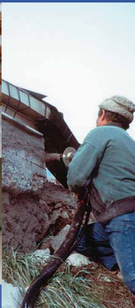
Eemaldage murenenud betoon lagunevalt konstruktsioonilt.
