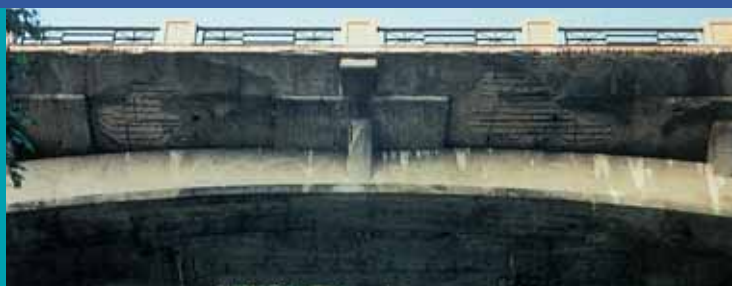
Eemaldage murenenud betoon lagunevalt konstruktsioonilt.
